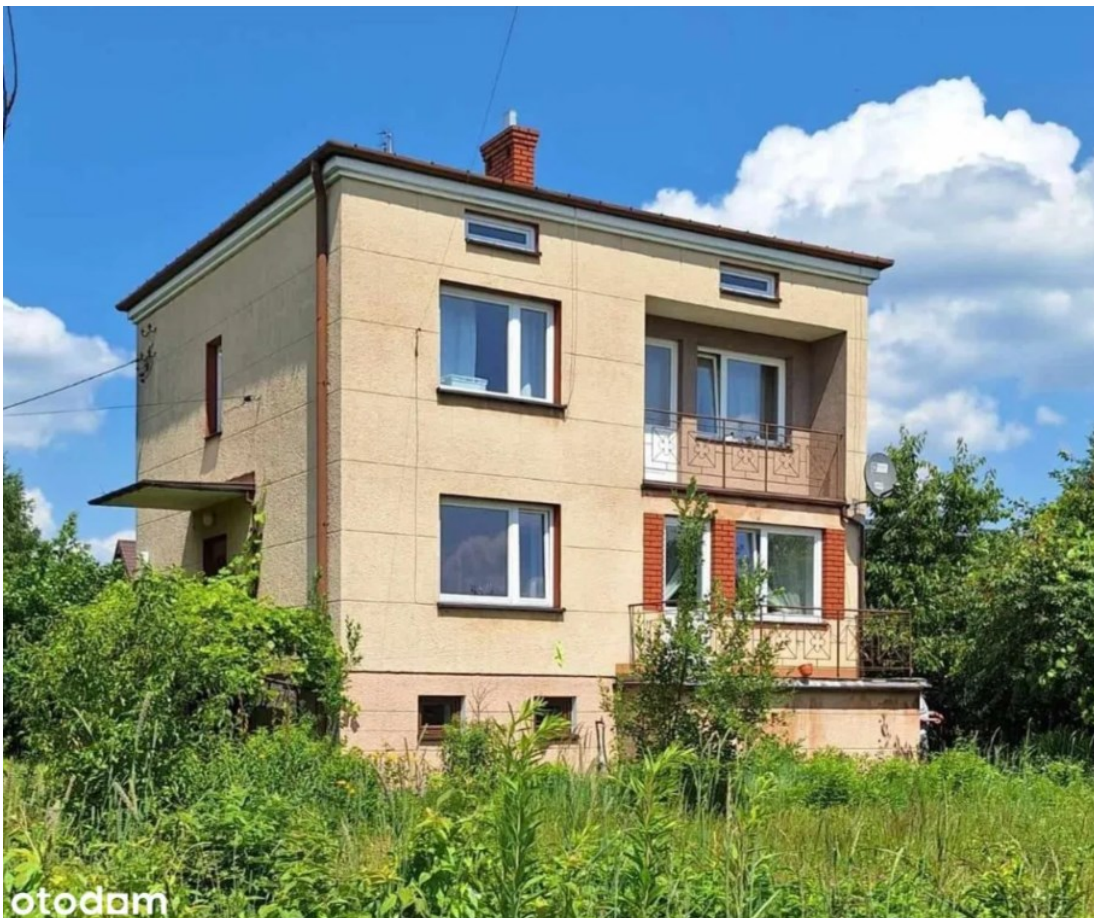
Łękawica, woj. Małopolskie, budynek z 1980 r.
