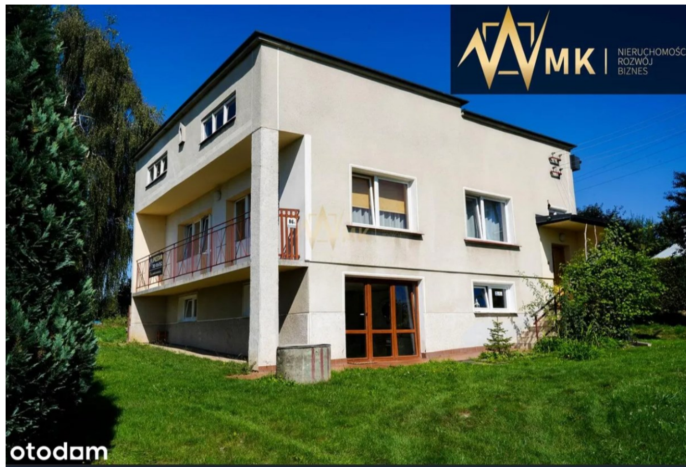
Piława, woj. Mazowieckie, budynek z 1976 r.
